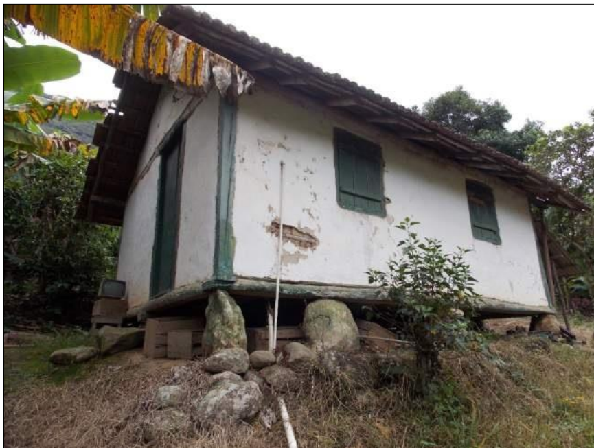
Figura 5 - Casa tipo em taipa de mão localizada no distrito de Lumiar
