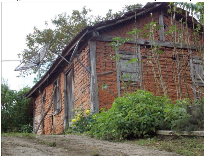
Figura 4 - Estrutura em enxaimel e as vedações em taipa
