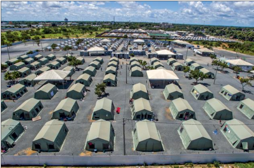
Figura 3 – Estrutura de abrigos
