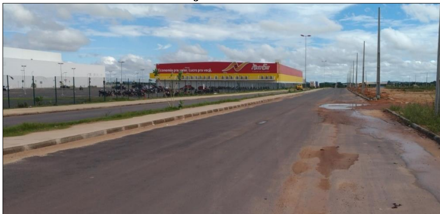
Figura 51 - Via principal de acesso ao futuro condomínio já dotada de infraestrutura
