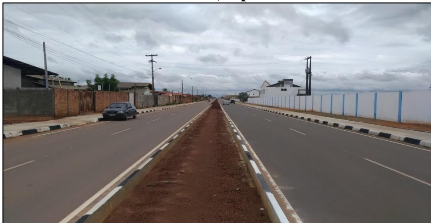
Figura 48 - Avenida Universo no bairro Cidade Satélite, depois do condomínio
