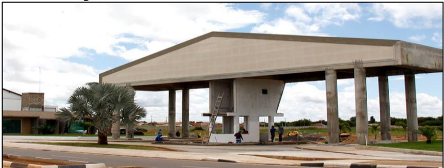
Figura 43 - Entrada do empreendimento com as obras em andamento
