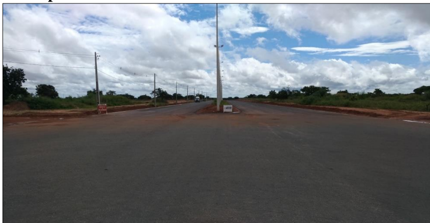
Figura 35 - Avenida Ville Roy pavimentada até a extensão do futuro condomínio
