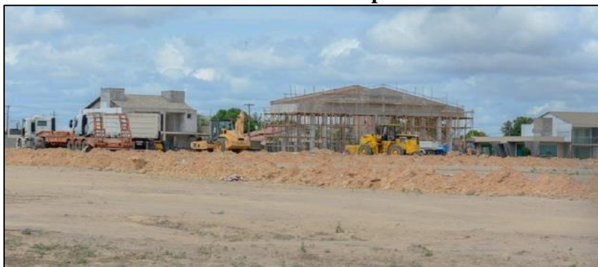
Figura 44 - Realização de obras na área interna do empreendimento
