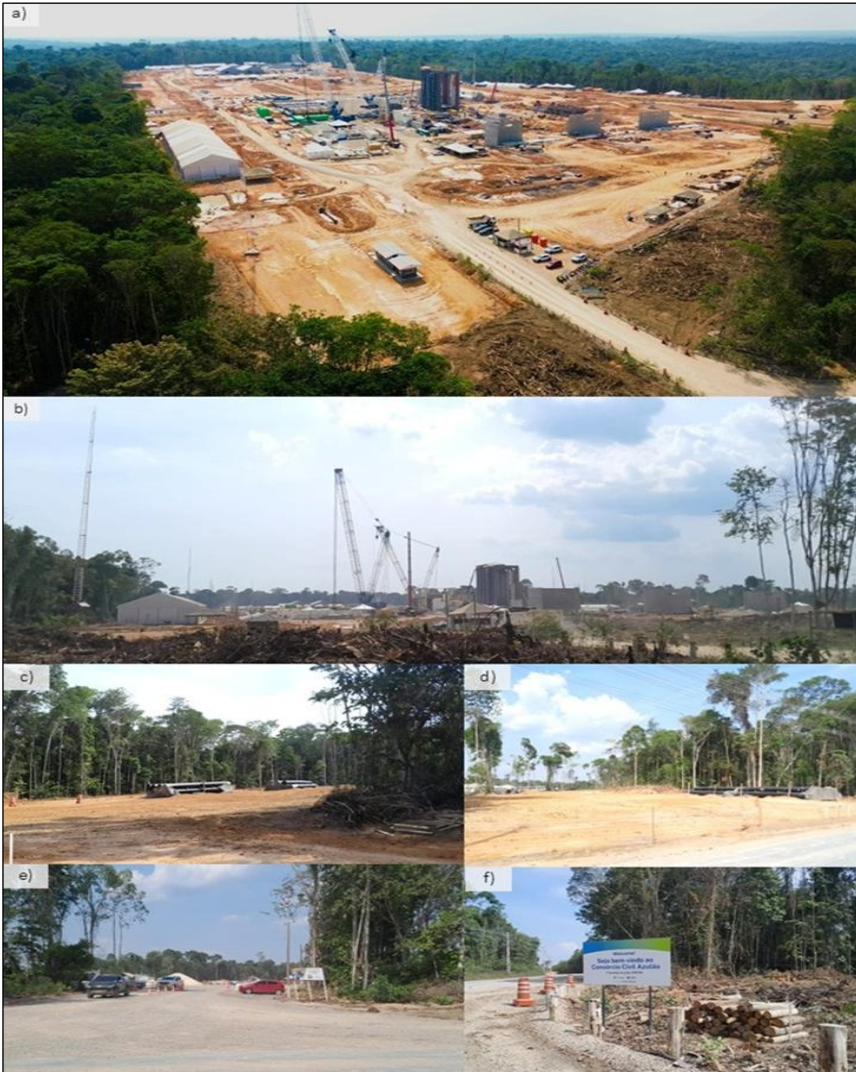
Figura 2 - Obras no complexo do Azulão
