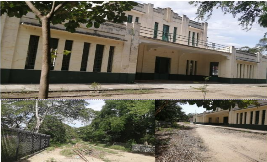
Figura 6 - Estación ferroviaria en Ambalema (Tolima)
