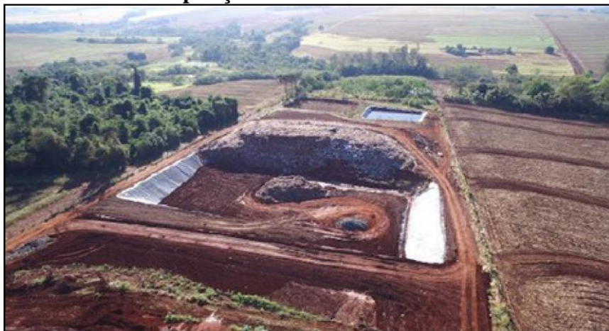
Figura 3 - Vala existente no sistema de disposição final de resíduos sólidos
