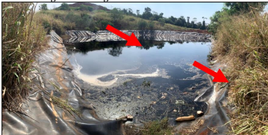
Figura 10 - Lagoa de tratamento de chorume
