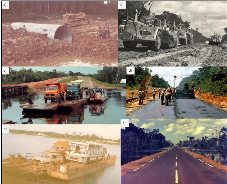
Figura 6 - Construção da rodovia BR-319
