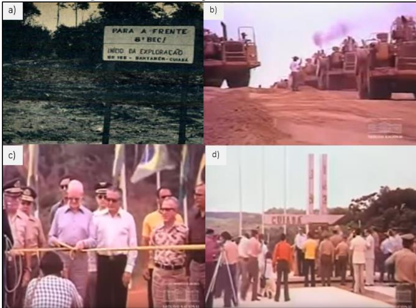
Figura 2 - Construção da rodovia BR-163
