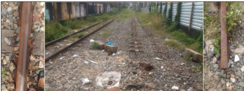
Figura 3 – Trilhos de ferro e parafusos retirados do Canteiro de obras – 1º Trecho em Santa Luzia do Lobato
